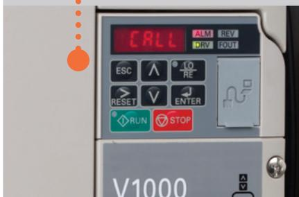
Agitateur de la cuve supérieure équipé d'un onduleur (variateur de vitesse) indépendant de 5 à 70 Herz, pour pouvoir chauffer et cuire des produits denses et limiter les échanges thermiques.
